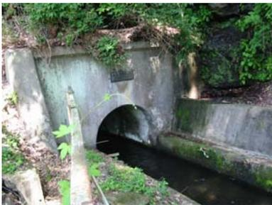
五郎兵衛用水掘抜き跡。現在もコンクリートで補強され使われています。
