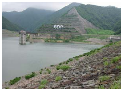
水源の日中ダム
